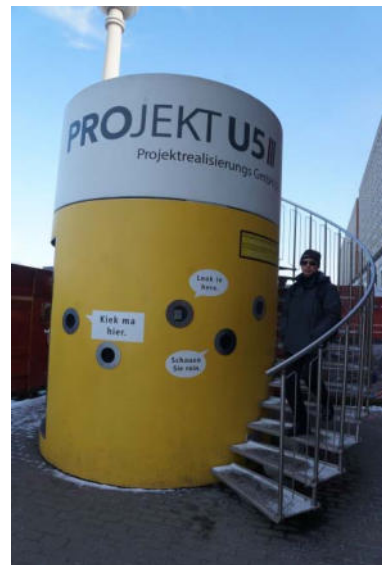
方便觀察工地的高臺
